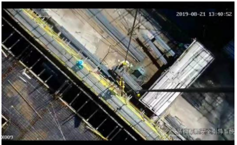
塔吊安全监控系统
